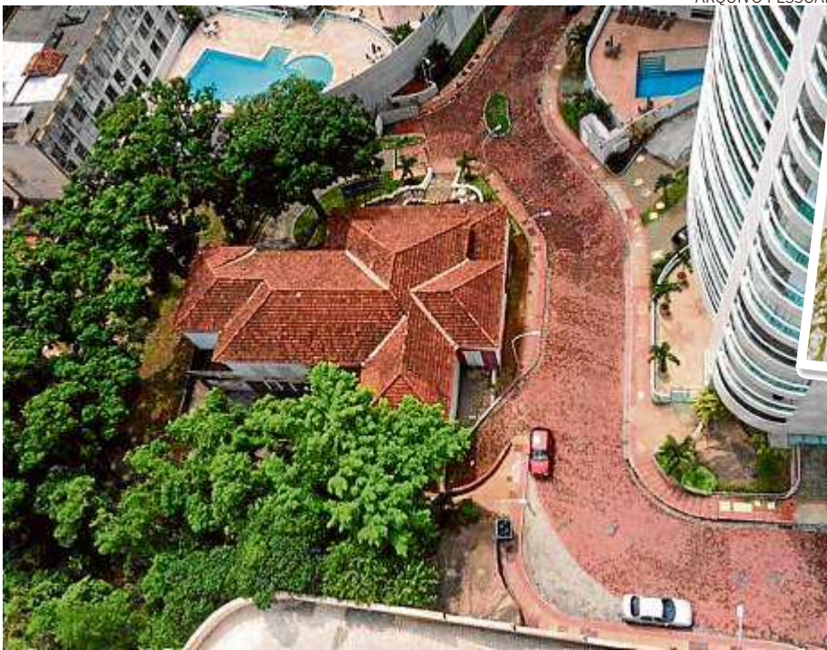
O casarão Von Schilgen hoje é cercado por quatro torres de edifícios
